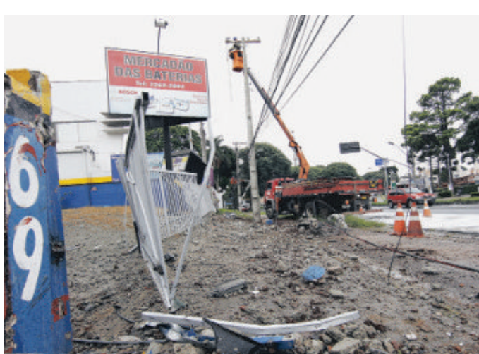
Segundo moradores, é a segunda vez que o portão foi destruído.
