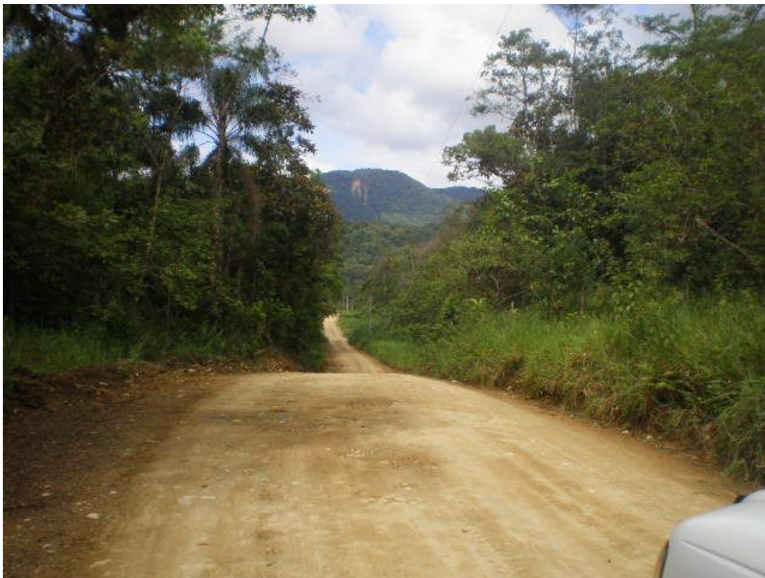
Figura 2.13 – km 20,0 do início, sentido norte - sul
