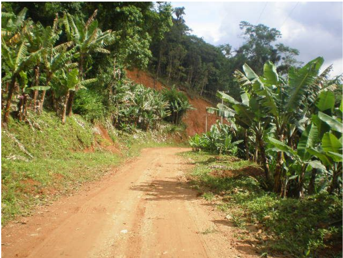
Figura 2.7 – km 5,0 do início, sentido sul - norte
