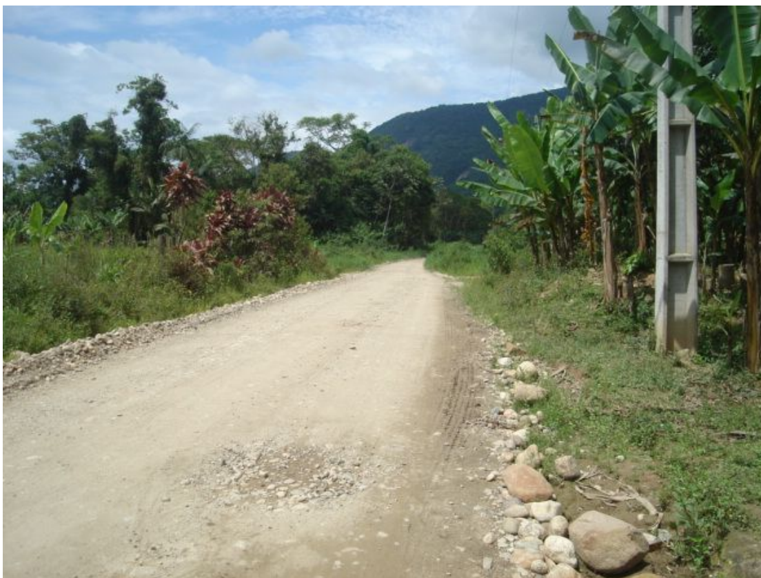
Figura 2.20 – km 45,0 do início, sentido norte – sul
