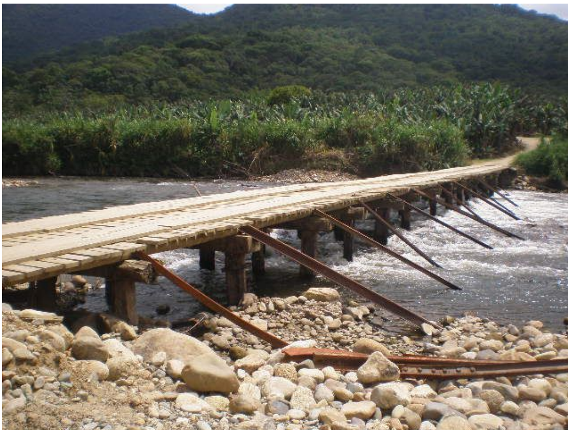
Figura 2.19 – km 41,0 do início, ponte sobre o rio Cubatão, sentido sul-norte
