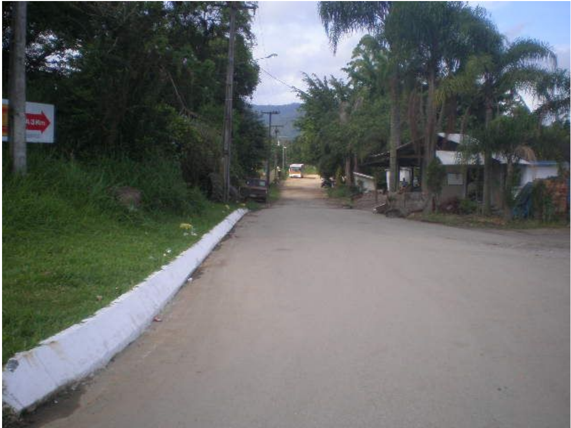
Figura 2.4 - Km 0,0, início da estrada rural no Patrimônio Marta, sentido norte - sul
