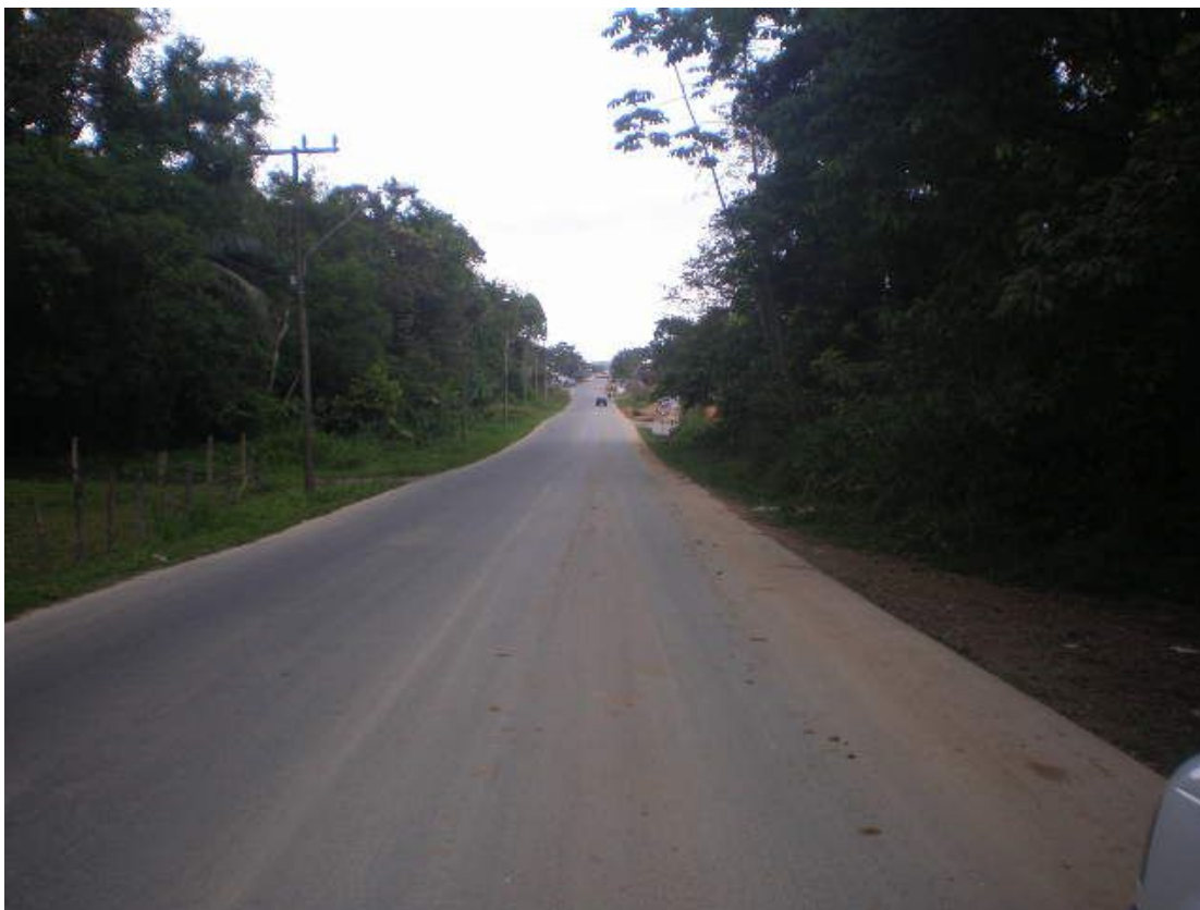
Figura 2.27 – km 69,0 do início – entrada de Garuva sentido norte – sul, em direção ao entroncamento semafórico da Avenida Celso Ramos com a rodovia SC-412
