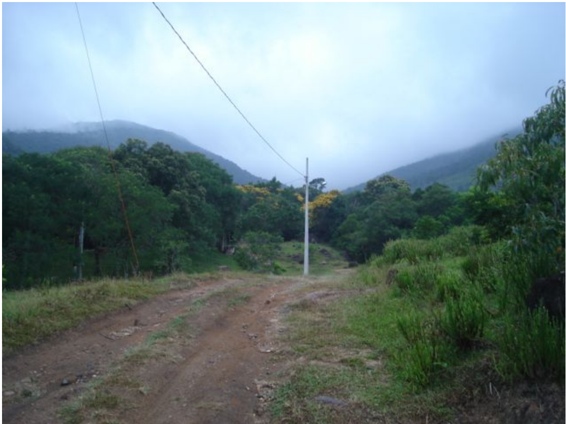
Figura 2.32 – km 3,0 do início, estrada da Samambaia, sentido norte - sul
