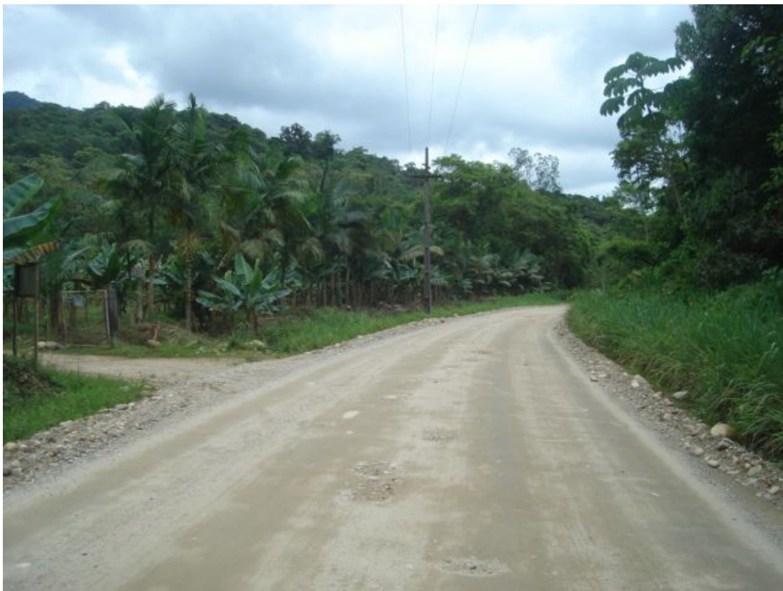
Figura 2.23 – km 55,0 do início, sentido norte – sul
