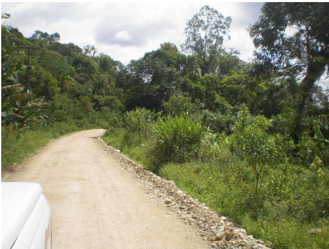
Figura 2.17 – km 35,0 do início, sentido sul-norte
