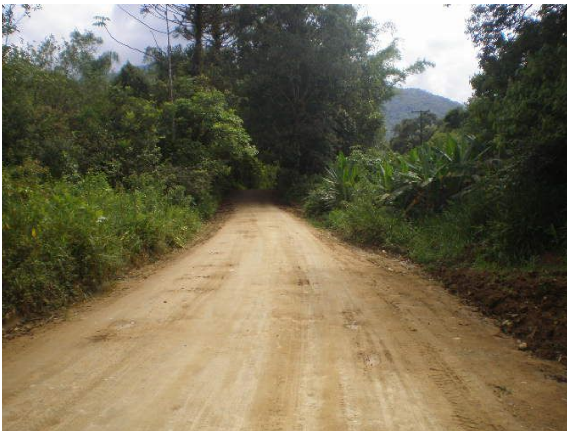
Figura 2.12 – km 20,0 do início, sentido sul - norte
