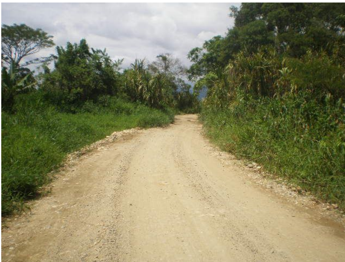
Figura 2.18 – km 40,0 do início, sentido norte - sul
