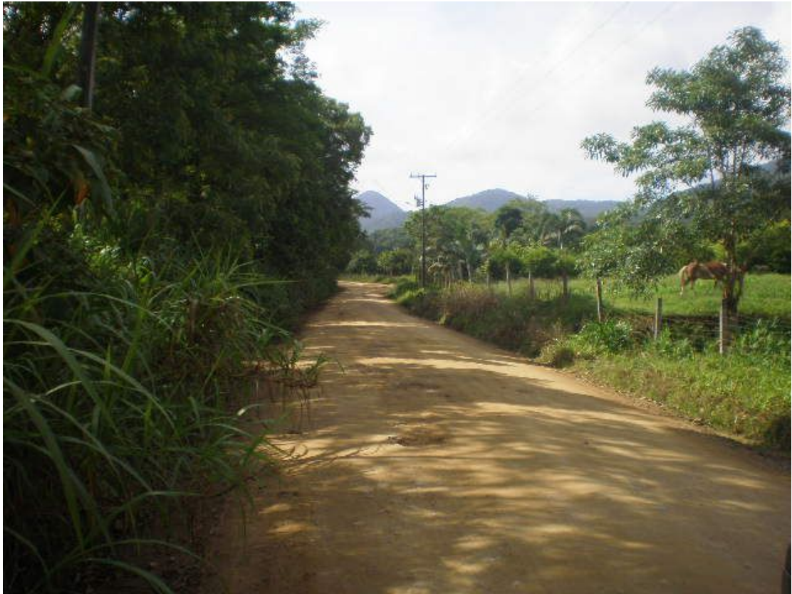
Figura 2.6 – km 5,0 do início, sentido norte - sul
