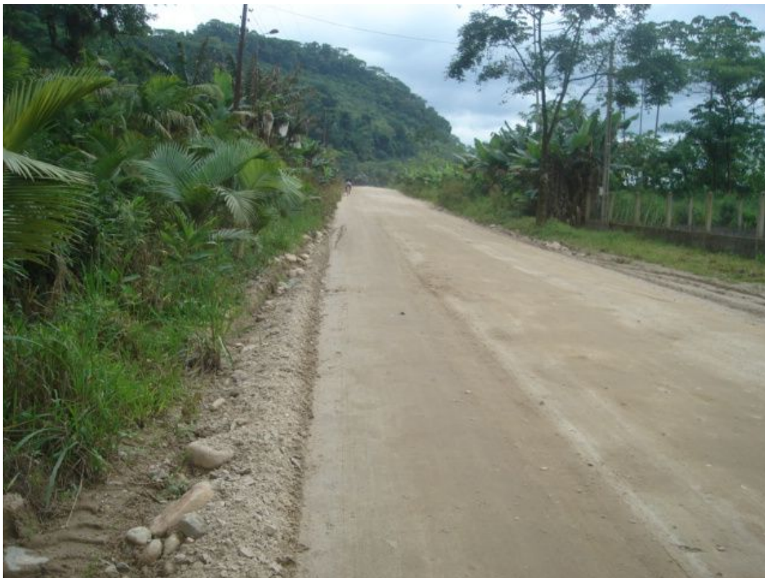
Figura 2.25 – km 65,0 do início, sentido sul - norte
