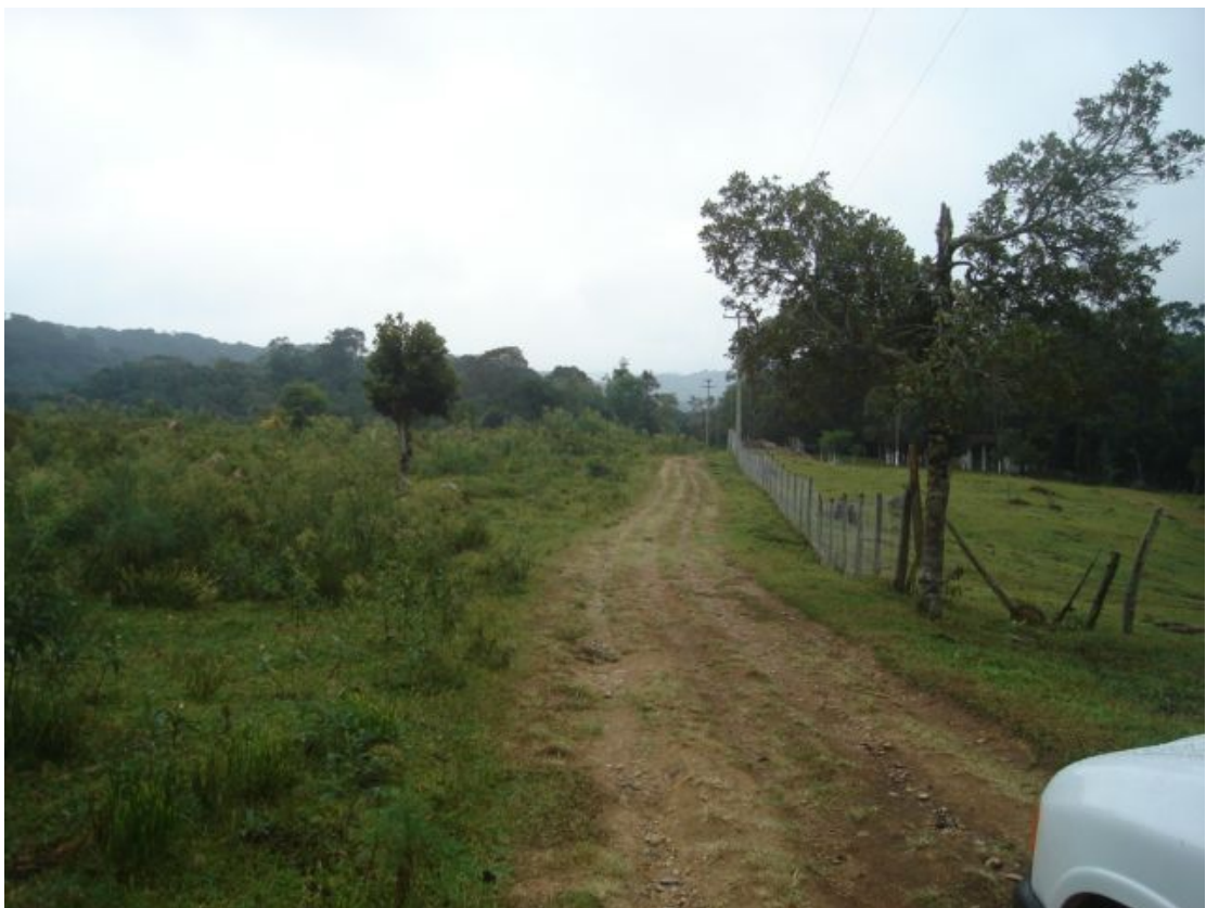
Figura 2.31 – km 2,0 do início, estrada da Samambaia, sentido norte - sul
