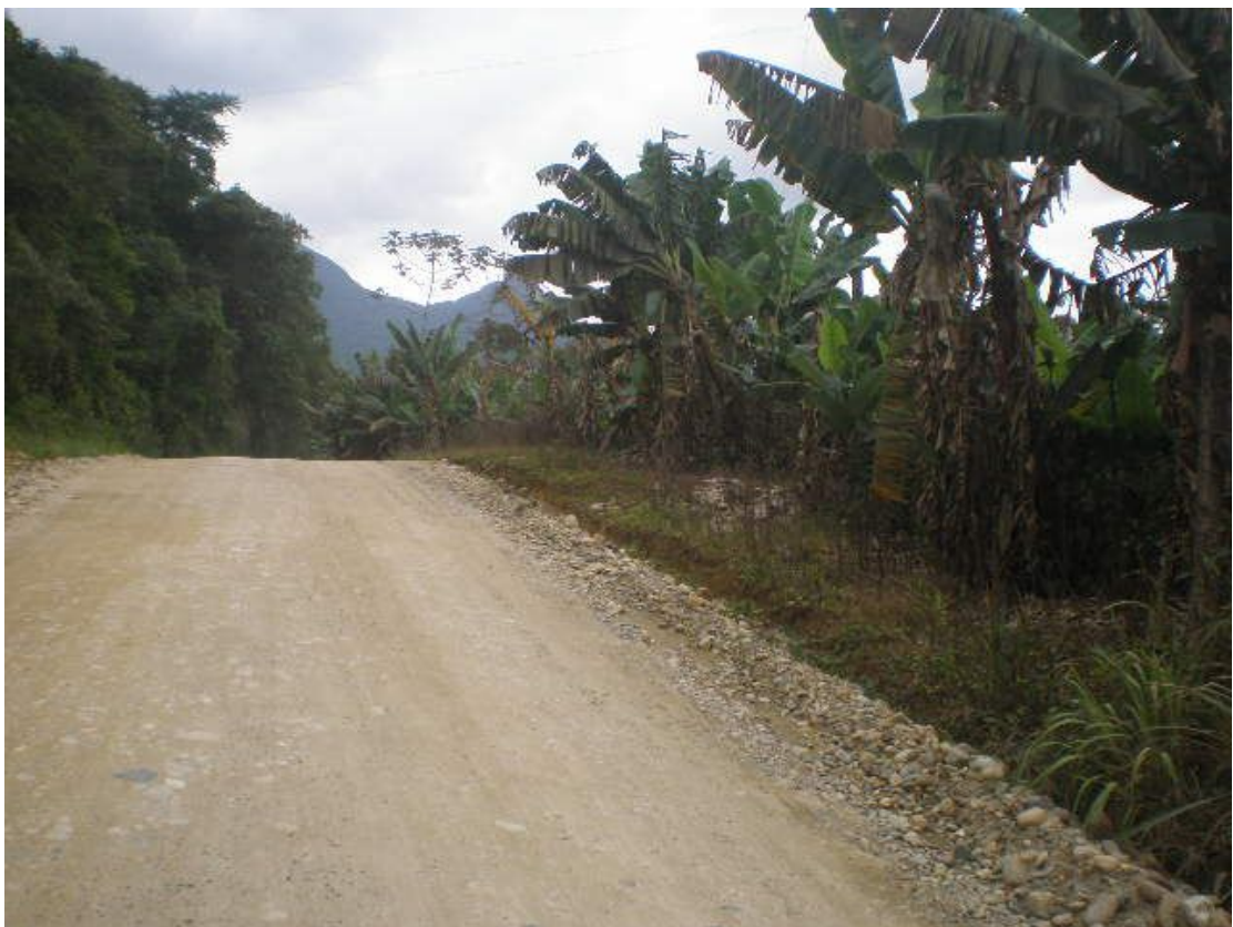
Figura 2.22 – Km 50,0 do início, sentido sul – norte
