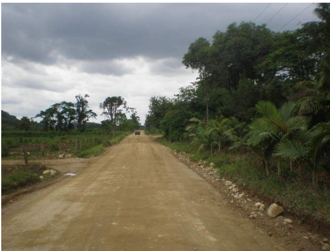
Figura 2.24 – km 60,0 do início, sentido norte – sul
