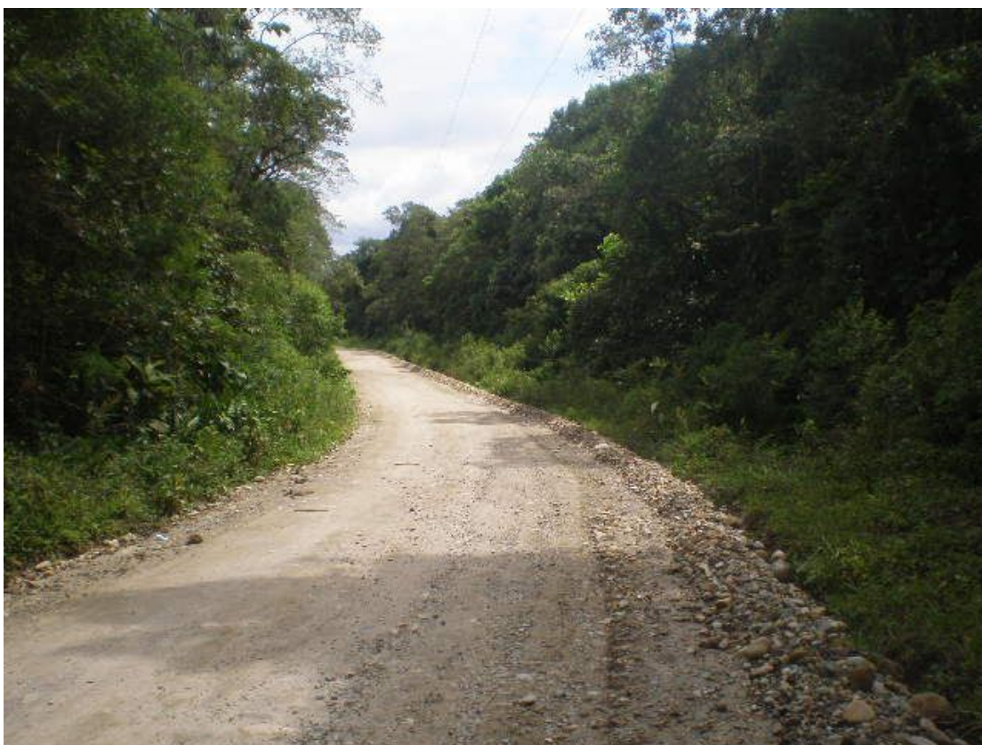
Figura 2.16 - km 30,0 do início, sentido norte – sul
