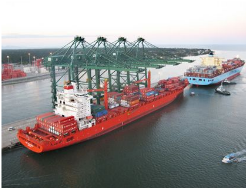
Figura 1.2 – Instalações do Porto de Itapoá, SC com navio atracado
